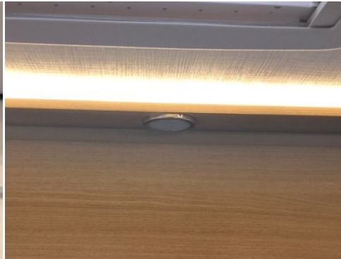
LED-Spots + Leuchtband an den Schränken
