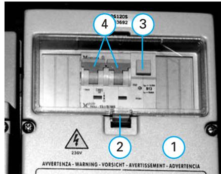
En cas de défaillance électrique ou de surcharge de l'installation électrique 230 volts, les fusibles (4) commutent en position « ARRET » dans les coupe-circuits automatiques (1) avec protection FI.
