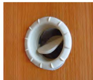
Lüftungsöffnung für warme Luft
