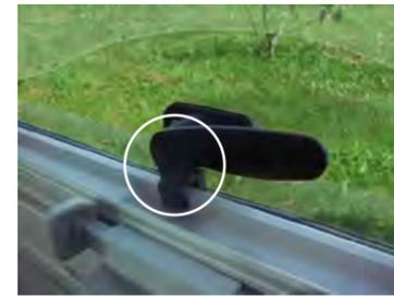
Die Fenster können auch in einer Stellung für Dauerbelüftung geöffnet bleiben, indem man den Hebel in die Ausparung der Fensterverriegelung einführt.
