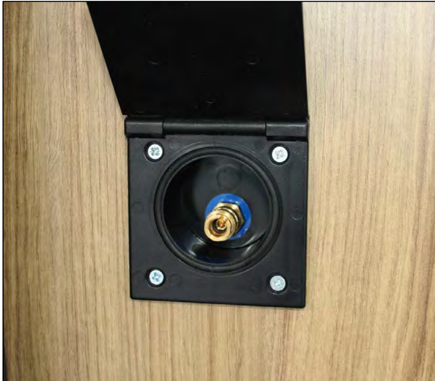
Zusätzlicher Duschanschluss (Abb. beispielhaft)
